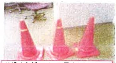
作業中作業エリアを示すカラーコーン
